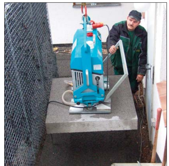
Kappa-Levator mit Elektromotor, Tragfähigkeit 800 kg.
